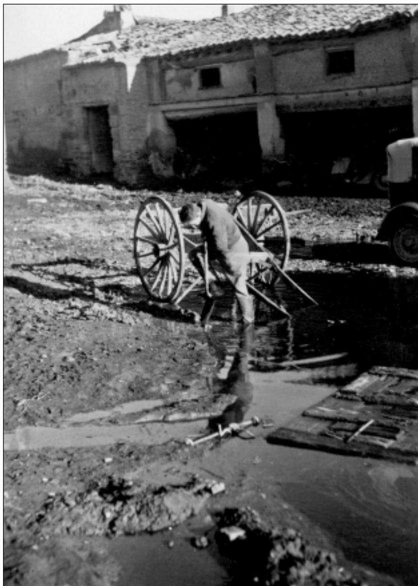
Estado del patio en el hospital de Grañén cuando se instaló la Unidad Médica Británica.
