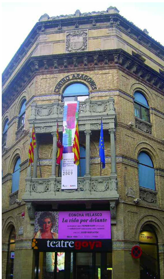
Fachada del Centro (2009)
