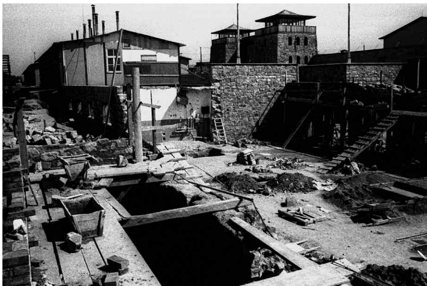
Construcción de los edificios de los SS, ubicados fuera del campo de prisioneros. Foto SS. Amical de Mauthausen
